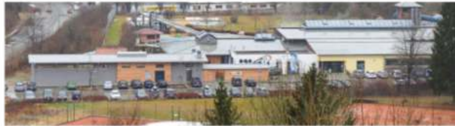
Das Plantsch aus Sicht der Altstadt: Direkt rechts neben dem Sauna-Neubau (grau-braun) sollte der eigene Eingangsbereich für die Sauna kommen. Den kann sich die Stadt laut Plantsch-Chef Andreas Kosian jetzt sparen.
